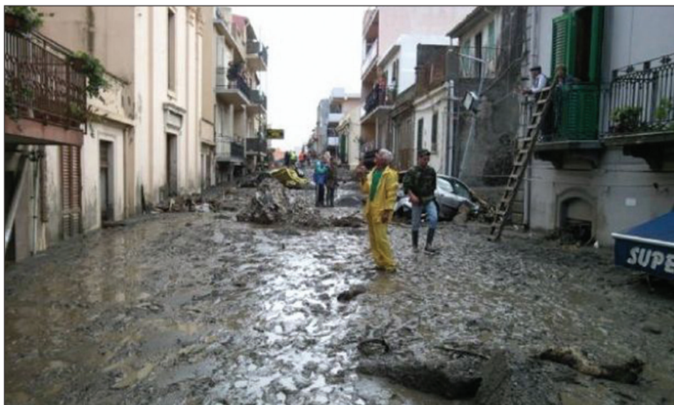
Messina: sfaldamenti, corrosioni, infiltrazioni...
